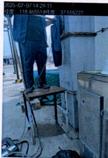
DA015 危废暂存间废气排气筒进口
